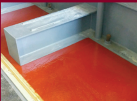
Completed Chockfast Red HF pour
